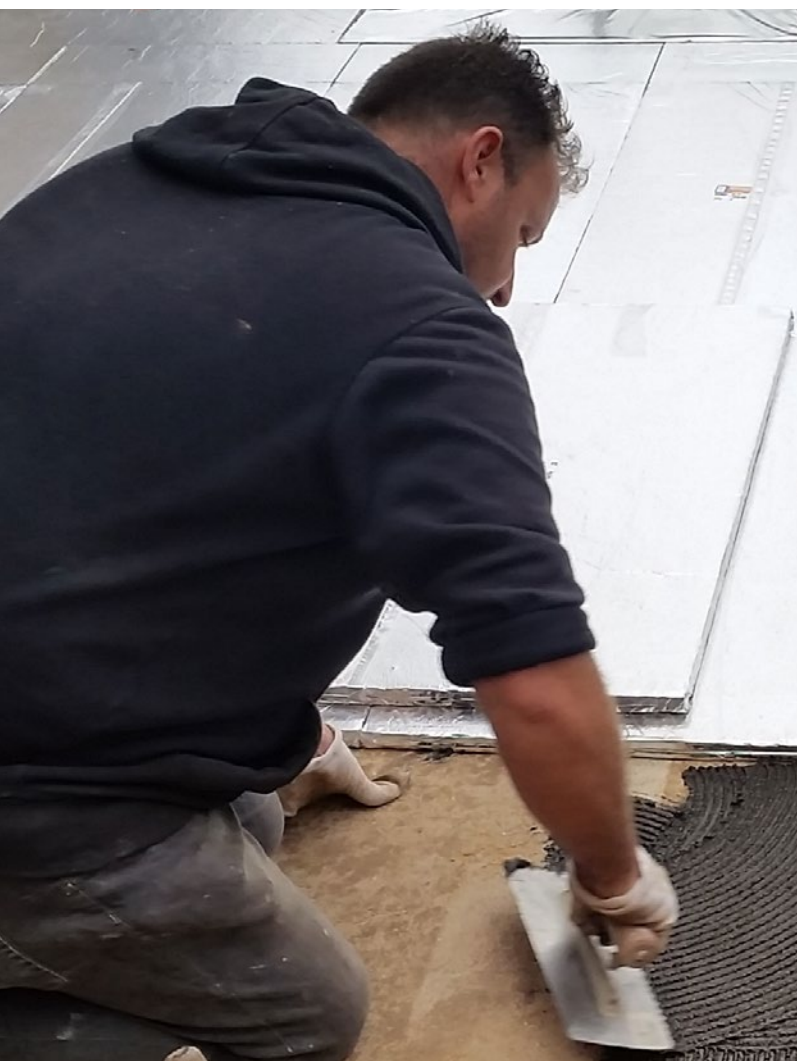
Isolazioni speciali con pannelli sottovuoto incollati.
