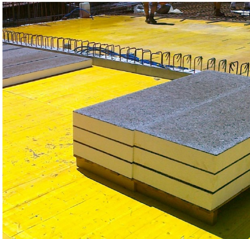
Isolamento termico sottosoletta posato in getto.
