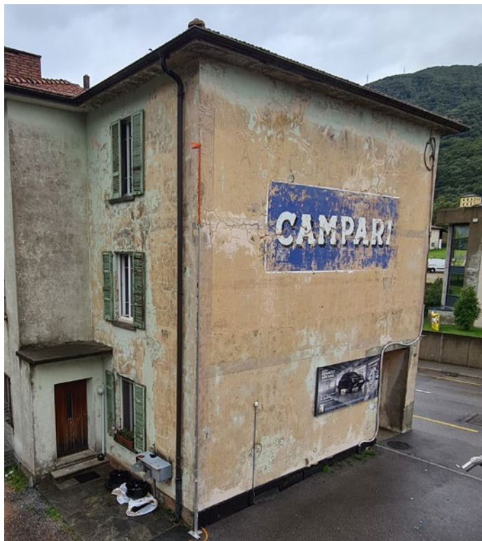
Trascuratezza degli edifici: a sinistra, facciate mai sottoposte a manutenzione. A destra: l'effetto di infiltrazioni d'acqua, correnti d'aria e muffe, nocivi per la salute.
