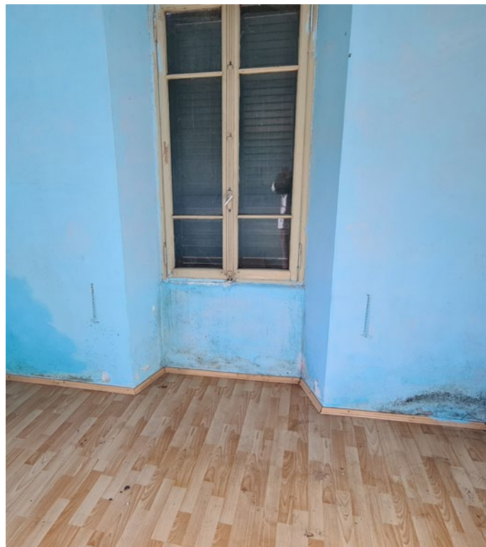
Trascuratezza degli edifici: a sinistra, facciate mai sottoposte a manutenzione. A destra: l'effetto di infiltrazioni d'acqua, correnti d'aria e muffe, nocivi per la salute.
