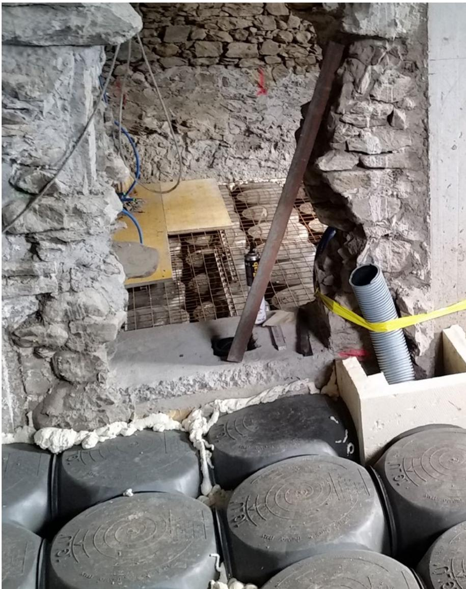
Sotto i pavimenti del piano giorno, gli elementi vuoti "igloo" sotto i quali scorre l'aria temperata che raggiunge la termopompa. Umidità ed eventuale gas radon vengono espulsi per la stessa via.
