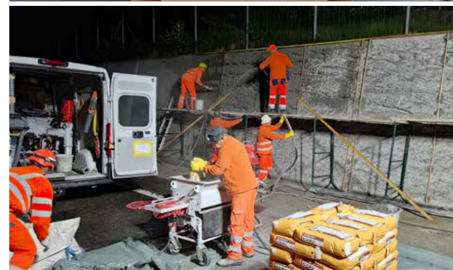
Dall'alto, pavimento corazzato impermeabile in resina epossidica, Azienda Cantonale Rifiuti ACR Giubiasco. Pavimento continuo in resina elastica, scuola dell'infanzia Sonvico. Risanamento muro di sostegno, strada nazionale N13 San Bernardino.
